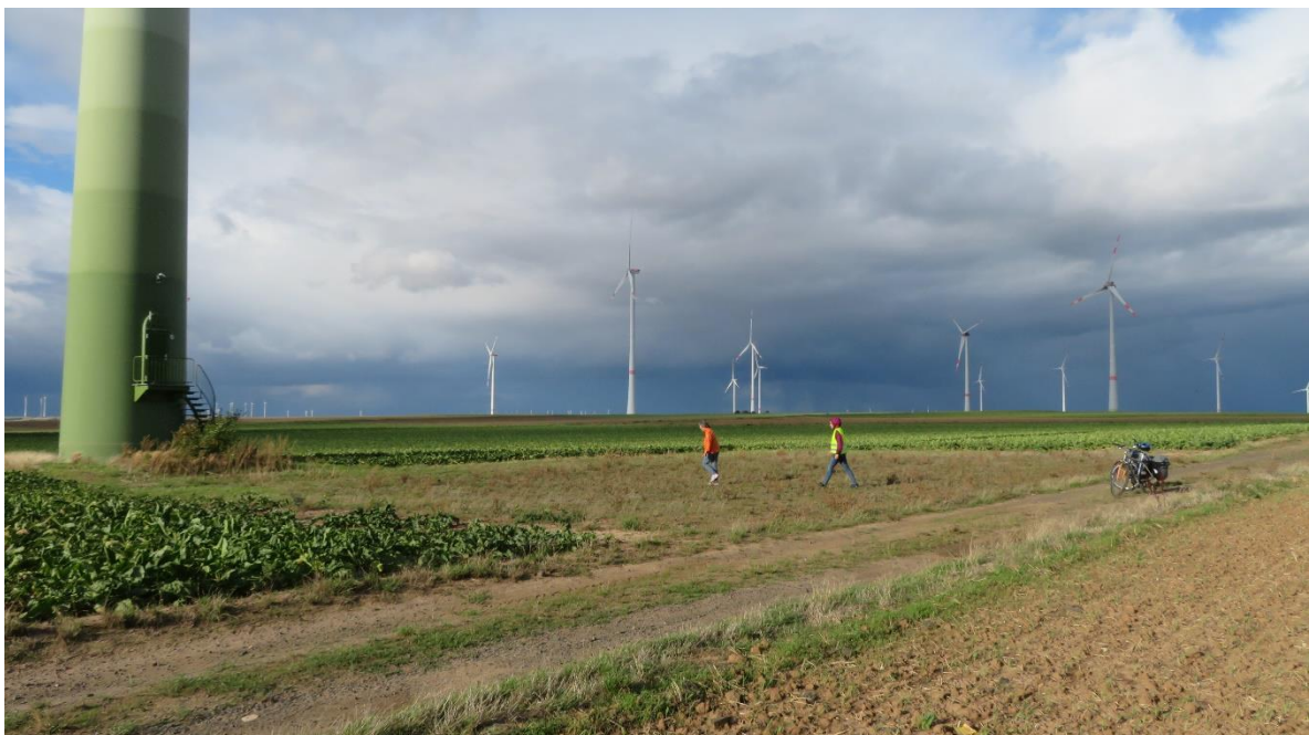
Bild 30: Windkraftwerke bei Biedesheim/Pfalz
