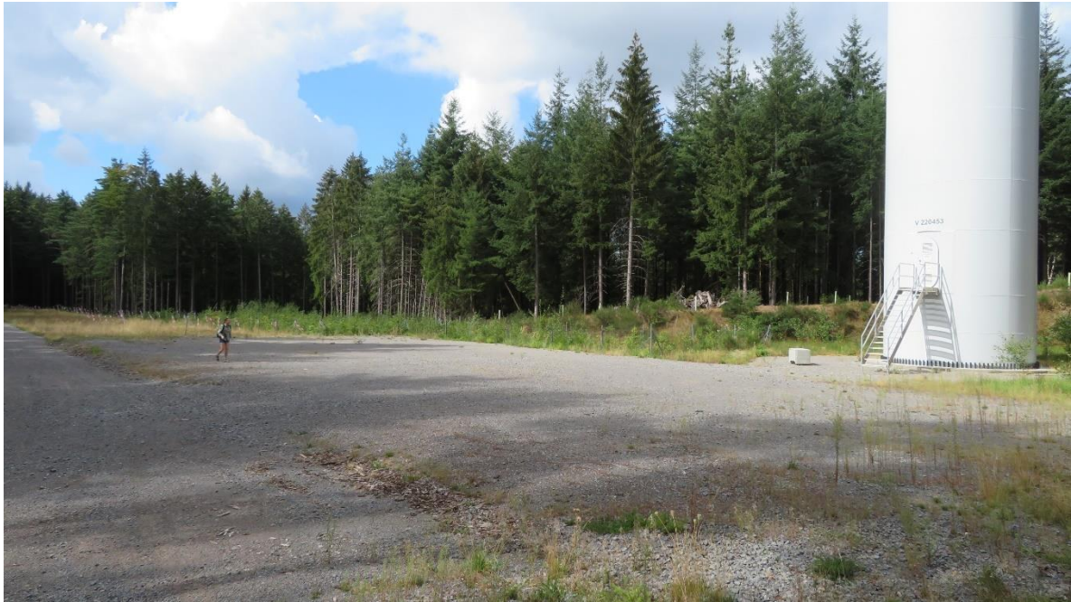
Bild 7: Geländemodellierung für Windkraftwerk (3,3 MW p 21 ) auf dem Gipfel des ursprünglich dicht bewaldeten Stillfüssels südlich Waldmichelbach
