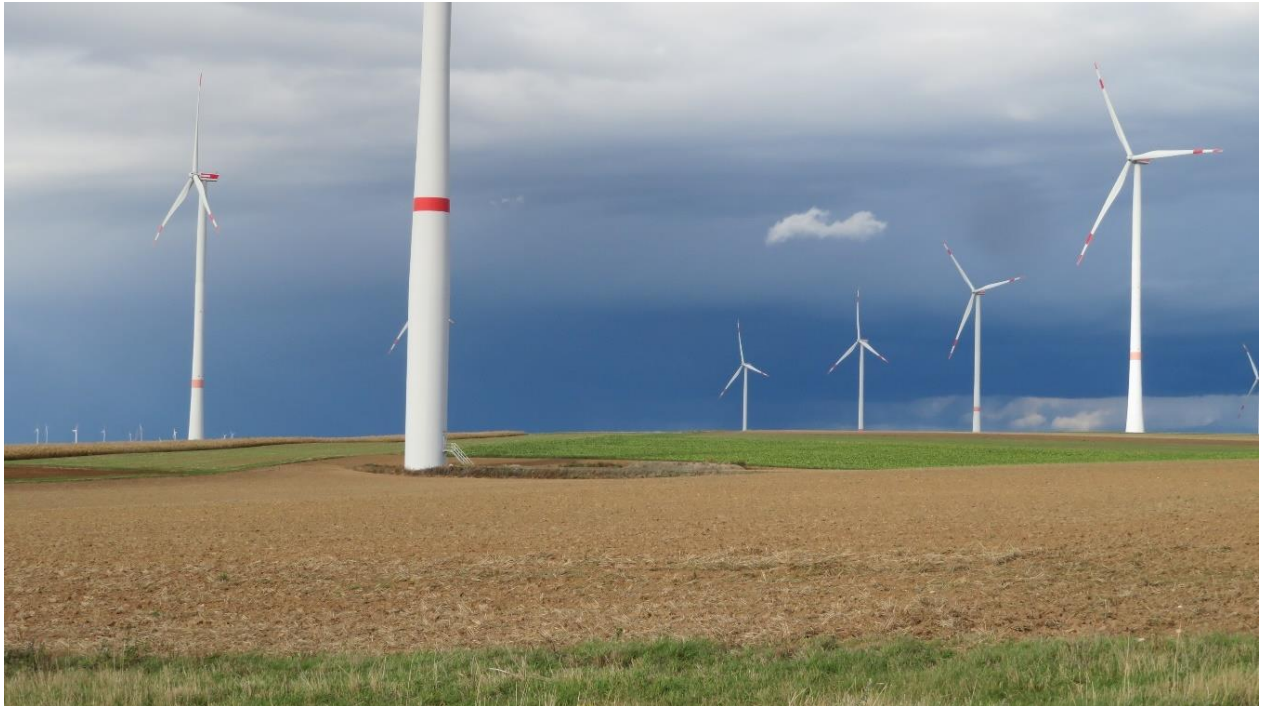
Bild 37: Windkraftwerke bei Biedesheim/Pfalz
